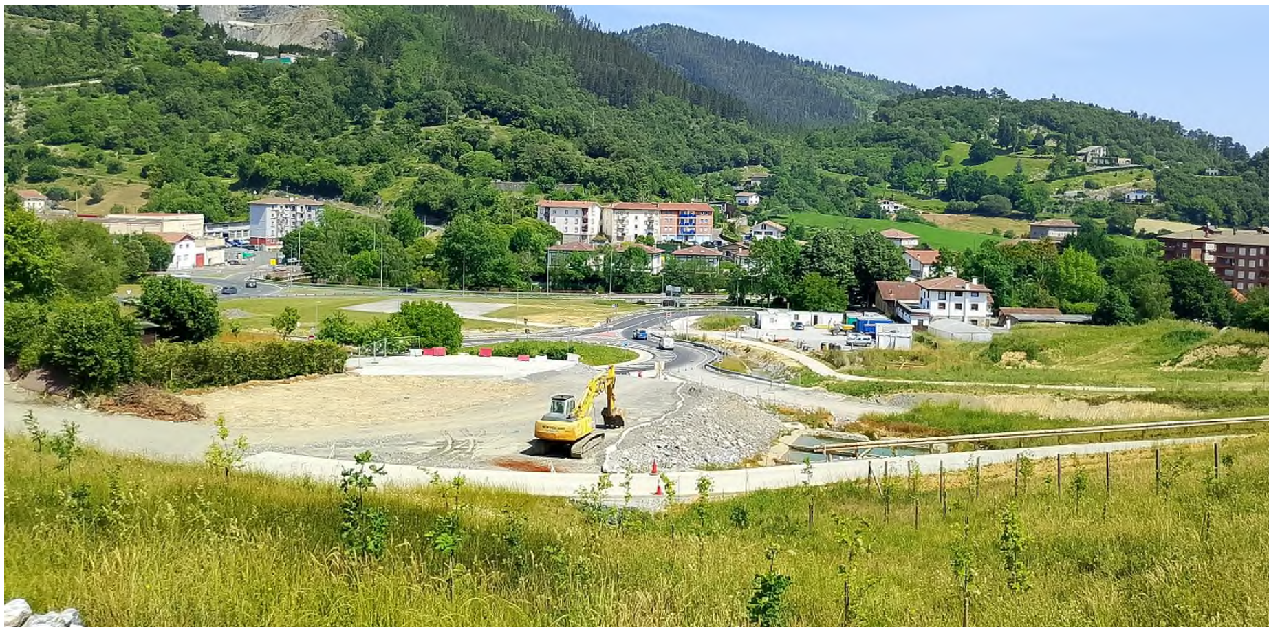
ROTONDA MARKINA, ZONA DE ACOPIO DE MATERIAL DE GAIMAZ PREVIO A LA SUBIDA AL DEPOSITO
