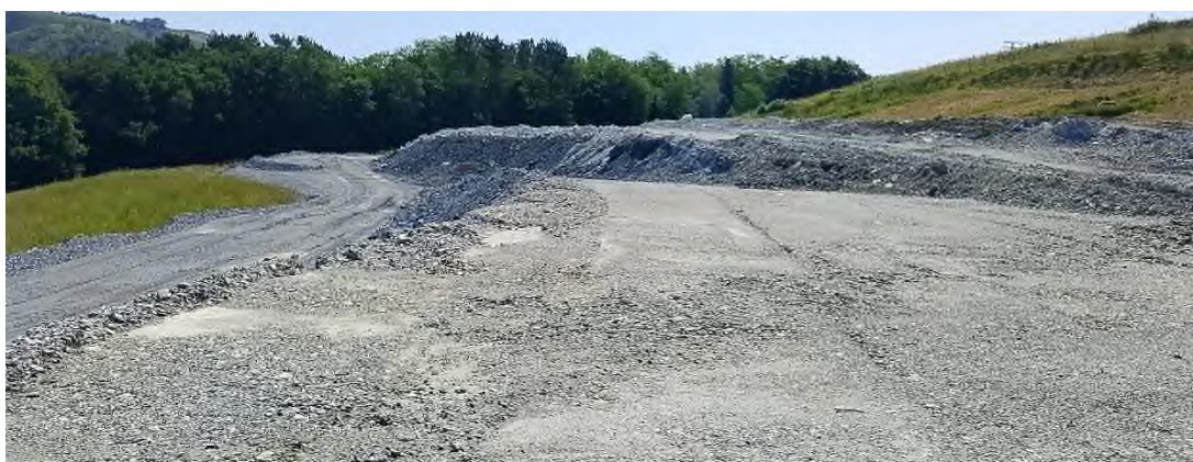
Foto nº49: Vista de explanada del depósito de sobrantes.
