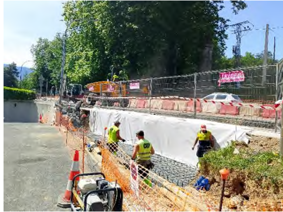
Foto nº6: Bidegorri: muro y urbanización.
