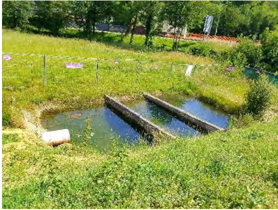
Foto nº24: Balsa decantación Etxebarria
