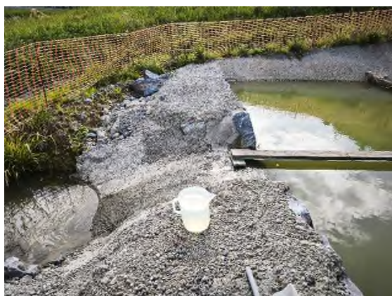
Foto nº50: Punto de vertido de la balsa de decantación del DS
