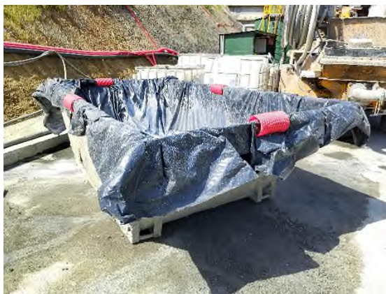
Foto nº30: Reposición de contenedor en S4 para la limpieza de canaletas.
