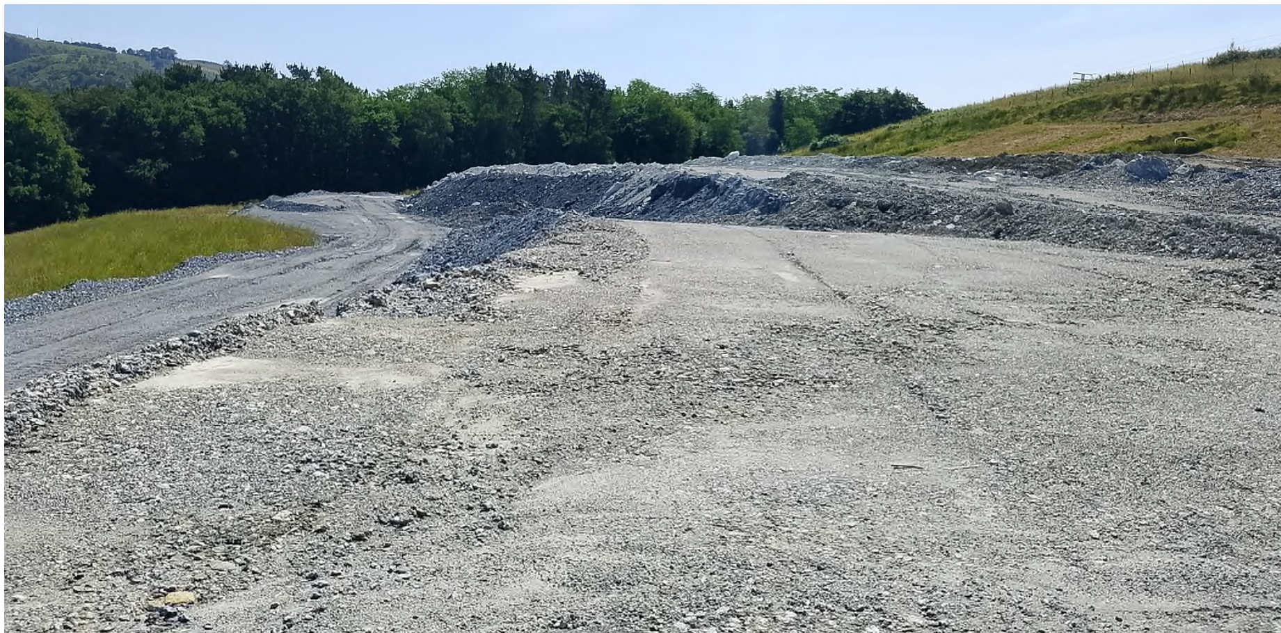
EXPLANADA DEPOSITO DE SOBRANTES
