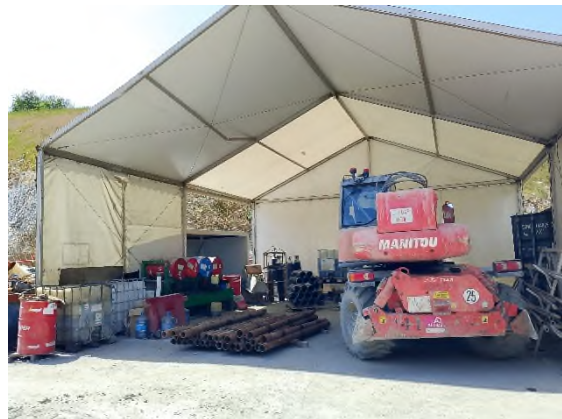
Foto nº34: Zona reparación maquinaria S-4
