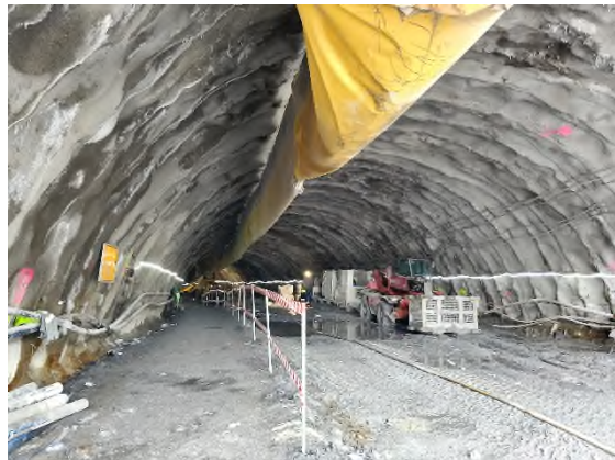
Foto nº2: Perforación en el túnel de Markina.
