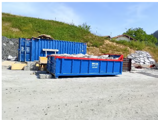
Foto nº42: Contenedores de restos de hormigón en S5, Etxebarria
