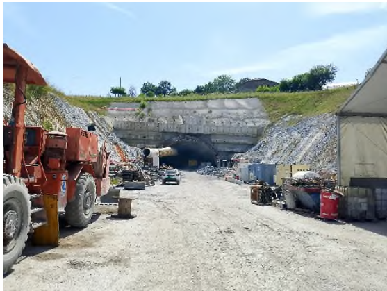
Foto nº31: Instalación auxiliar S4
