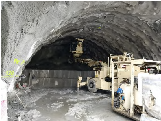
Foto nº1: Trabajos estabilización boca este.
