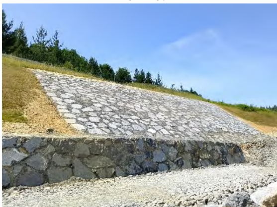
Foto nº47: Entorno a la piel de escollera del eje-21 Markina.
