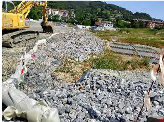
Foto nº23: Barrera de geotextil en el eje 30
