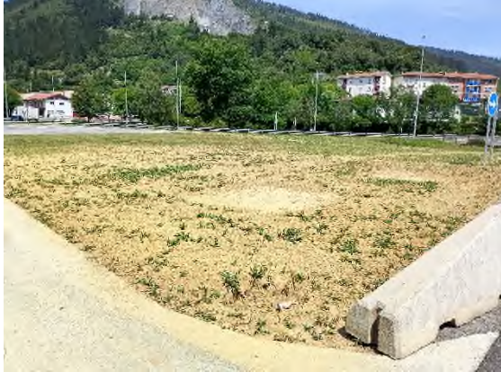
Foto nº43: Zona helipuerto tras laboreo e hidrosiembra
