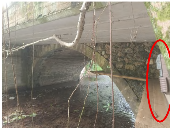
Foto nº57: Camara instalada en la MC3
